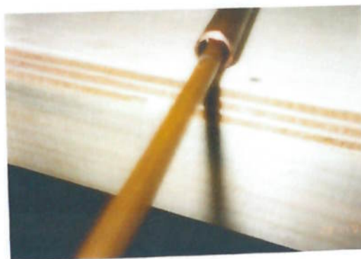
Figura 7: Detalhe dos tubos do trocador antes da tampa de vedação
